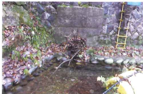
(a) 魚道出口(撤去前)
