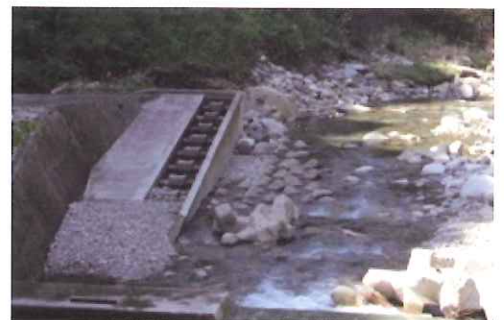
(b) 魚道入口(撤去前)
