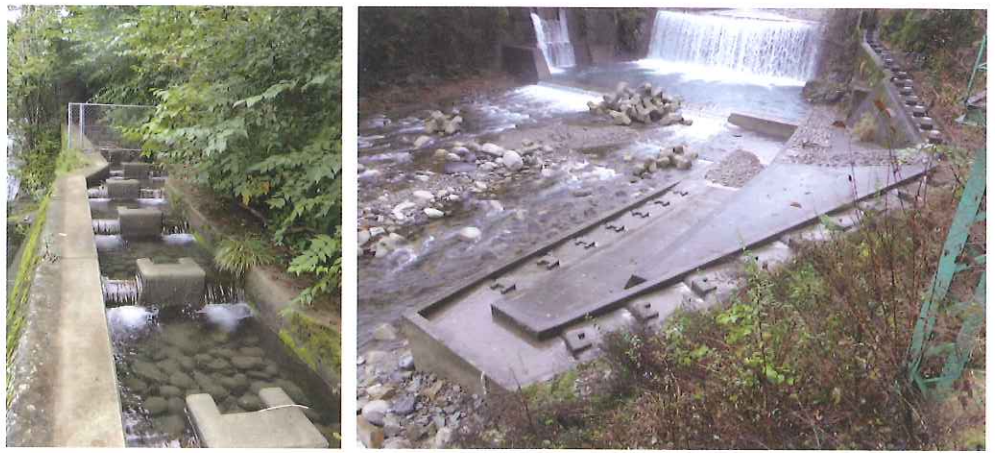
図2 吉田川・二間手魚道(アイスハーバー型)
