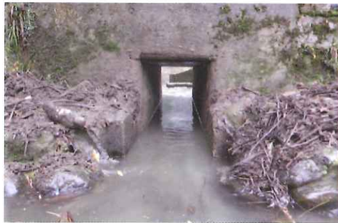
(d) 魚道入口(撤去後)
